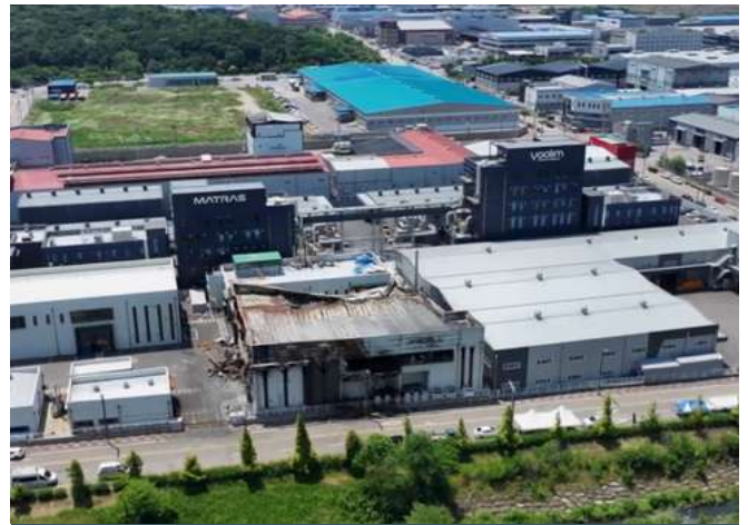
Vista aérea de la planta de Aricell en Hwaseong, Corea del Sur, luego del incendio del 24 de junio de 2024. El caso dejó 23 trabajadores fallecidos y abrió una investigación penal sobre las condiciones de seguridad industrial.
